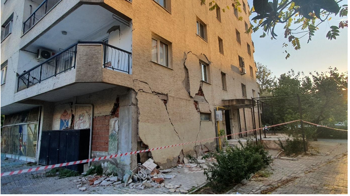
Fotoğraf 5. Bayraklı ilçesinde bodrumsuz 8 katlı bir betonarme binada zemin ve 1. kat hasarı.
