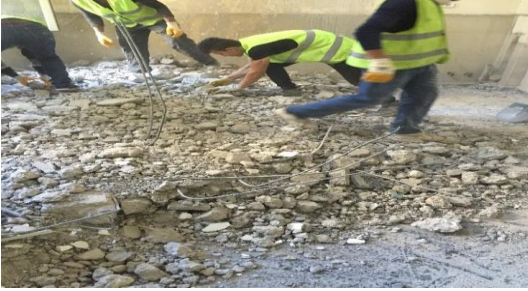
Fen Fakültesi Laboratuvar Binası Tad. İş
