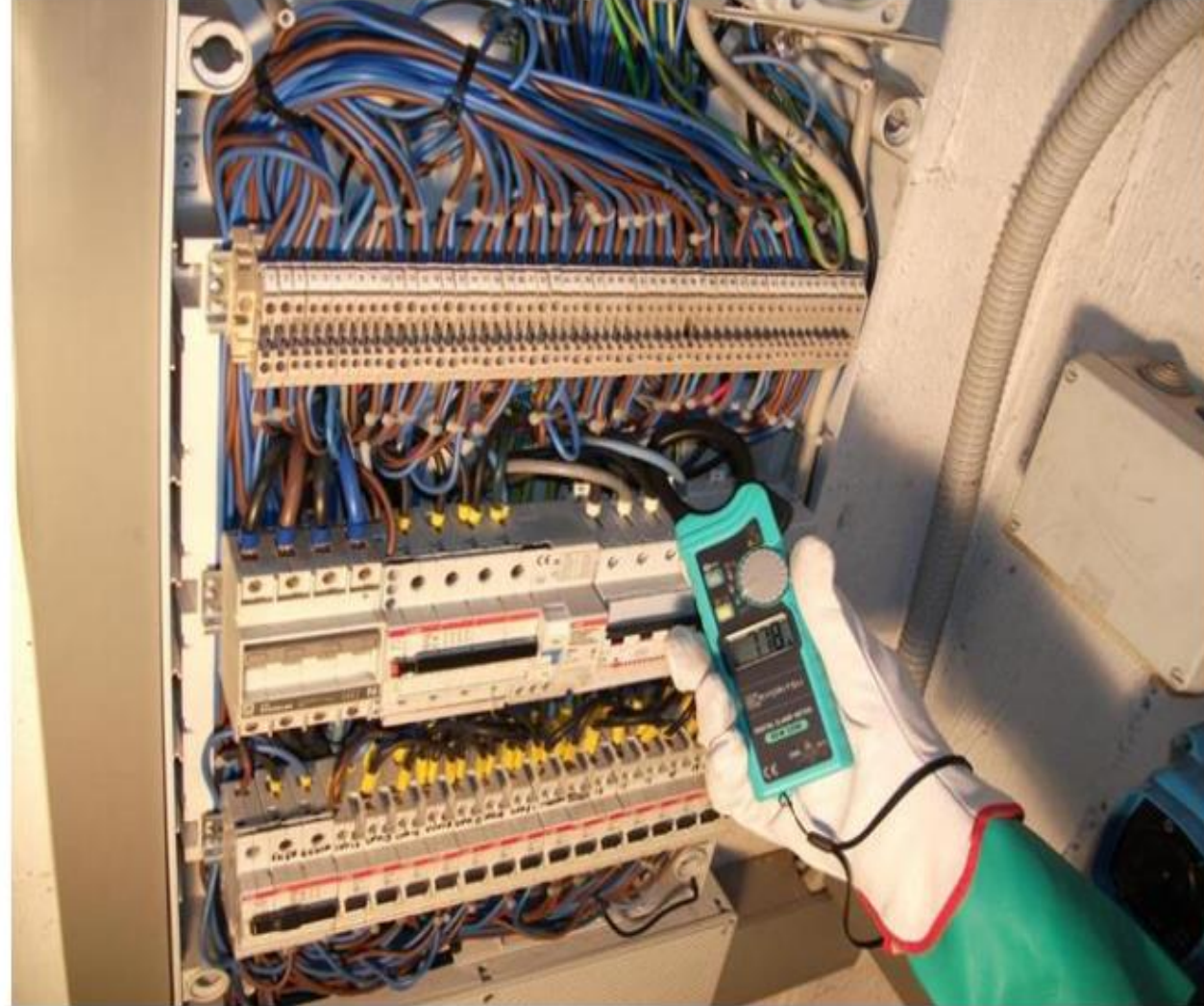
Şekil 15: Bir hattın pensampermetre ile ölçümü
